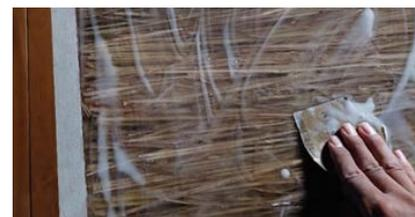
Gambar 28. Proses Ampelas Air
