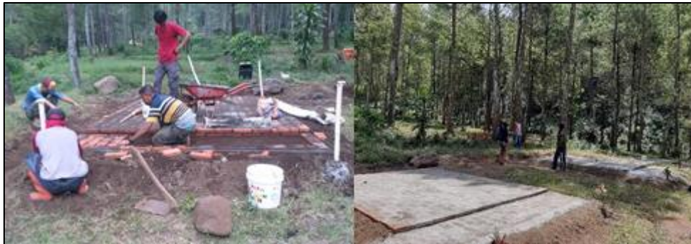
Gambar 4. Proses konstruksi pondasi area penempatan tenda (Sumber : Dokumentasi pribadi)
